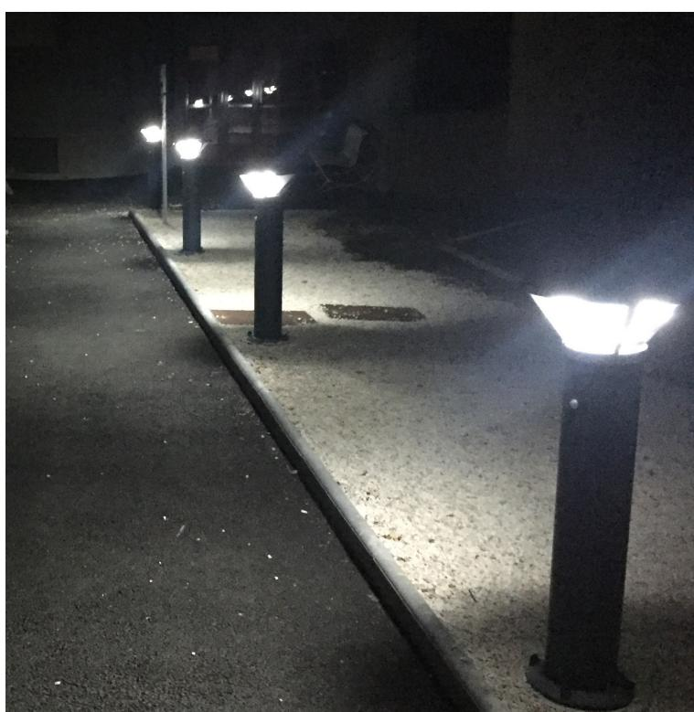
Borne spéciale avec détecteur de présence et double batteries lithium pour obtenir une puissance de 20 LUX pour les besoins PMR (Personnes à mobilité réduite).
